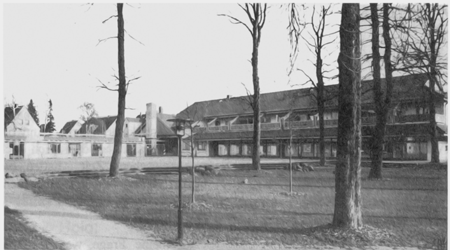
Das Dach auf dem "Bankengebäude" ist mit Städtebaufördermittel erst möglich geworden. Es prägt jetzt unser Ortszentrum positiv.
