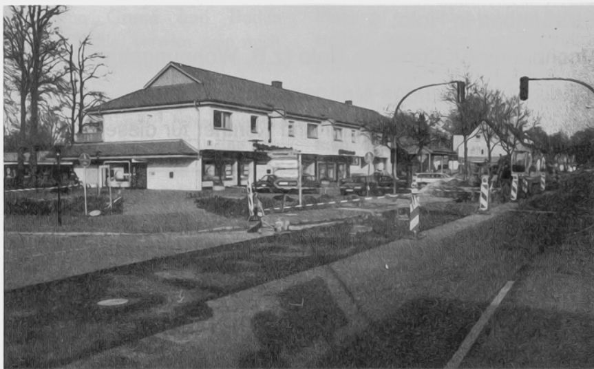
Bei den Buddelarbeiten in der Kieler Straße werden auch neue Trink- und Abwasserleitungen verlegt.
