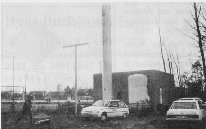
Der Bau des BHKW's schreitet endlich zügig voran
