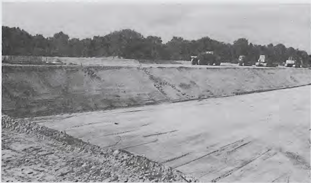
Großbaustelle Rieselfelder: In 3 m tiefen Becken soll Abwasser geklärt werden.
