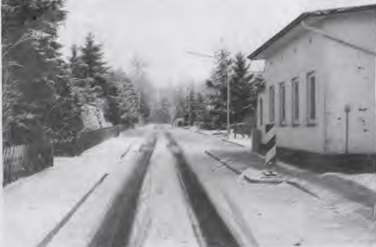
Beginn der Realisierung des SPD-Konzeptes. Verkehrsberuhigung durch Fahrbahnverengungen in der Schneidemühlstraße.
