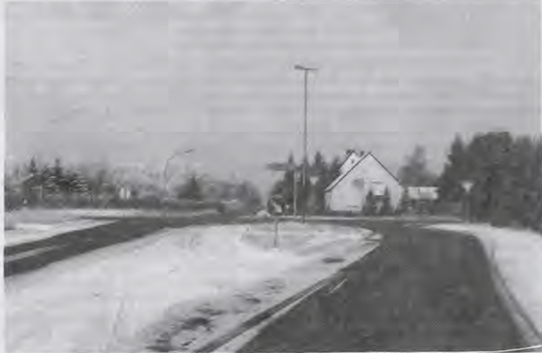
Kreuzungsbereich Kieler Straße/Hermann-Löns-Straße/Ridderser Weg. Der Wartepflichtige kann übersehen, daß der auf der Gegenseite von links kommende Radfahrer vorfahrberechtigt ist.
