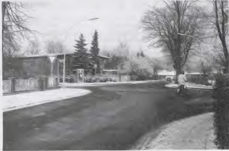
Versetzte Kreuzung und unklare Verkehrsführung können zu Mißverständnissen führen.
