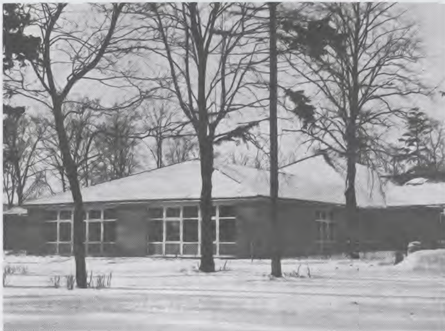
Die eingeschneite Grundschule von Hohenlockstedt. Noch ohne Innenleben. Ist das der Zweck einer Schule?
