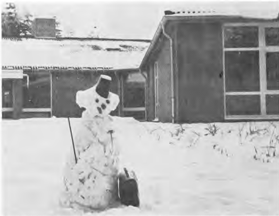
Beim Warten auf die Fertigstellung seiner neuen Schule bekam ein Schüler zuerst kalte Füße. Dann wurde das Klima noch kälter und frostiger, und der Schüler wurde zu Eis und Schnee. Da steht er nun als Schneemann und wartet weiterhin.
