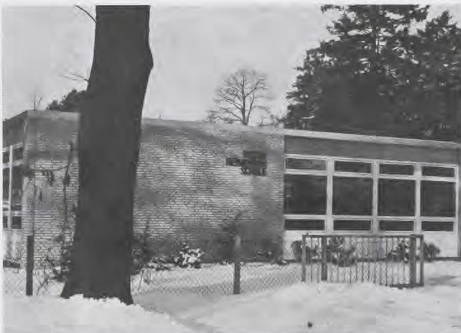
Die Außenwand der neuen Schulräume mit dem kunstgeschmiedeten Namenszug.
